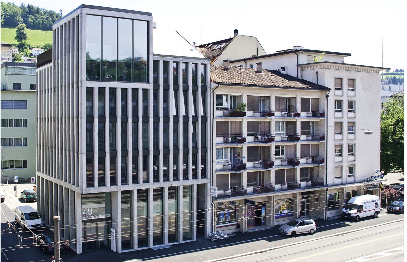
Hugo Steiner-Haus, St. Leonhard-Strasse 49, 9001 St. Gallen.
