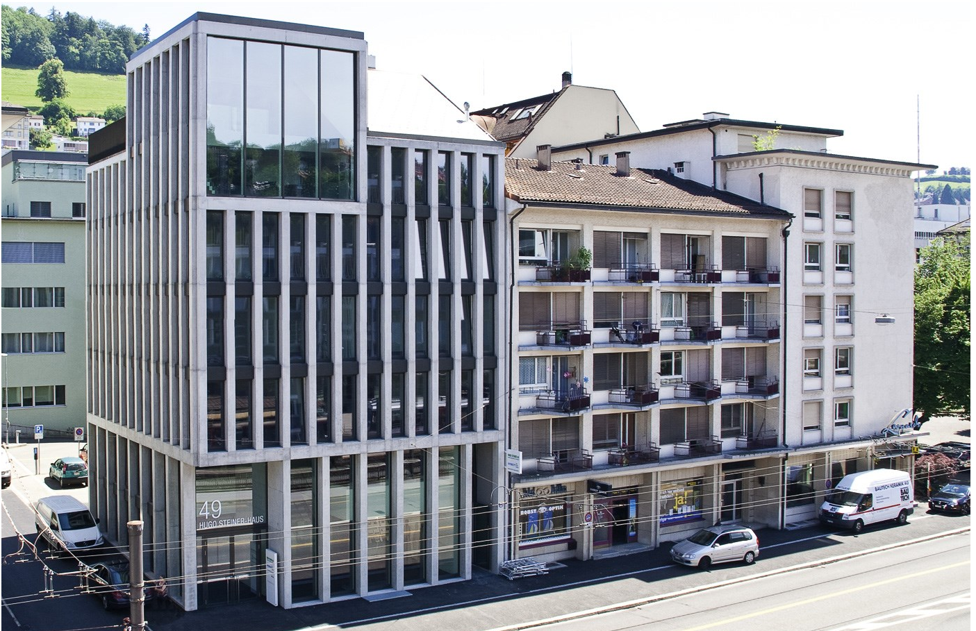
Hugo Steiner-Haus, St. Leonhard-Strasse 49, 9001 St. Gallen.
