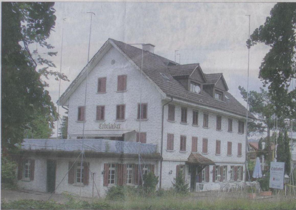
Noch steht das Restaurant Tobelacker. Die Baugespanne künden aber bereits das Ende einer Ära an: Das Restaurant muss einem Mehrfamilienhaus weichen. (wo)
